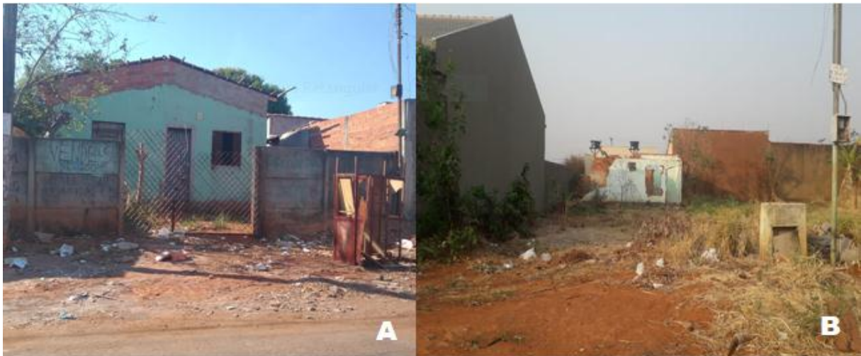
Figura 11: Registros fotográficos de casas abandonadas encontradas no território de abrangência de ESF Residencial Marise em Trindade/GO, Brasil, 2019.
