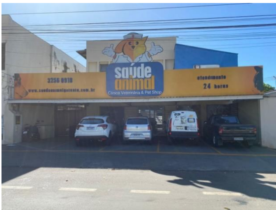
Figura 1 - Fachada da Saúde Animal Clínica Veterinária e Pet Shop LTDA.
