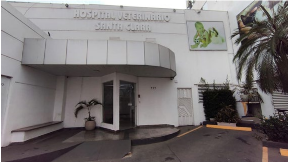
Figura 1 - Imagem externa da fachada do Hospital. Fonte: arquivo pessoal (2024).
