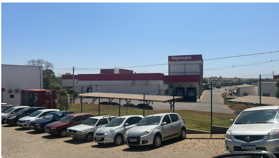
Figura 1: Fachada do Frigorífico Suíno Sol Nascente.
