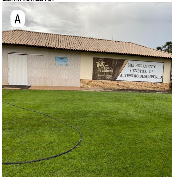
Figura 7 – A fachada do escritório. B sala de espera. C sala de reunião. D sala do administrativo.
