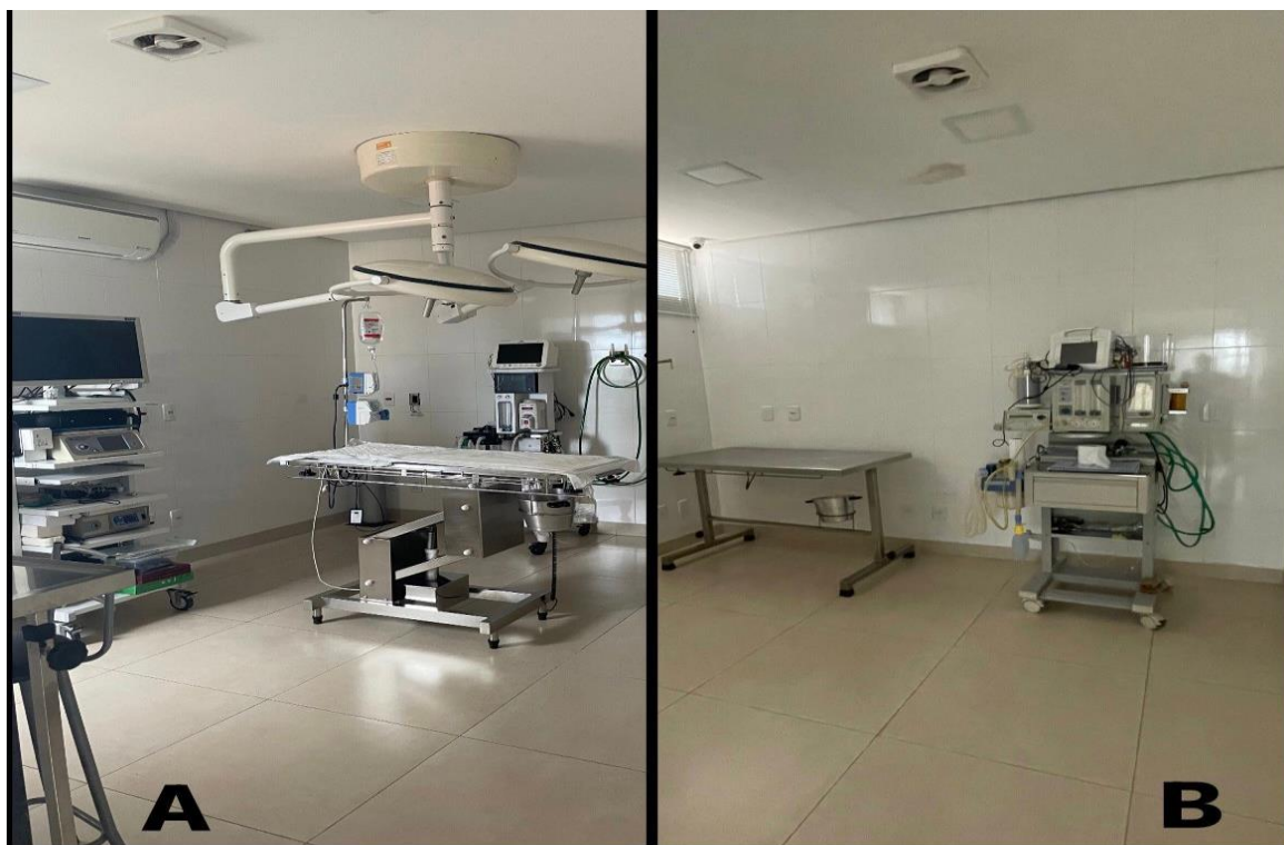
Figura 5 - Instalações do centro cirúrgico. Centro Cirúrgico I (A); Centro Cirúrgico II (B). Fonte: Arquivo pessoal, 2024.
