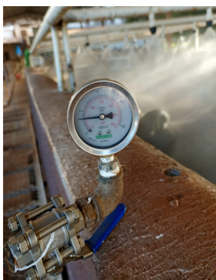
Figura 7: Esfigmomanômetro da pressão da água do banho de aspersão.
