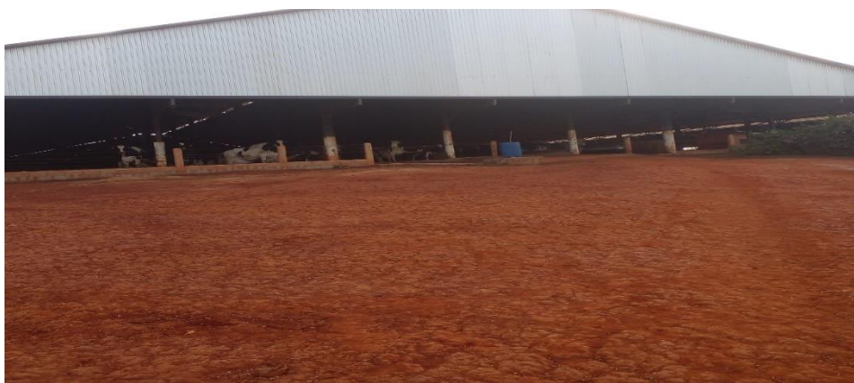
Figura 12 - Fachada do Galpão
