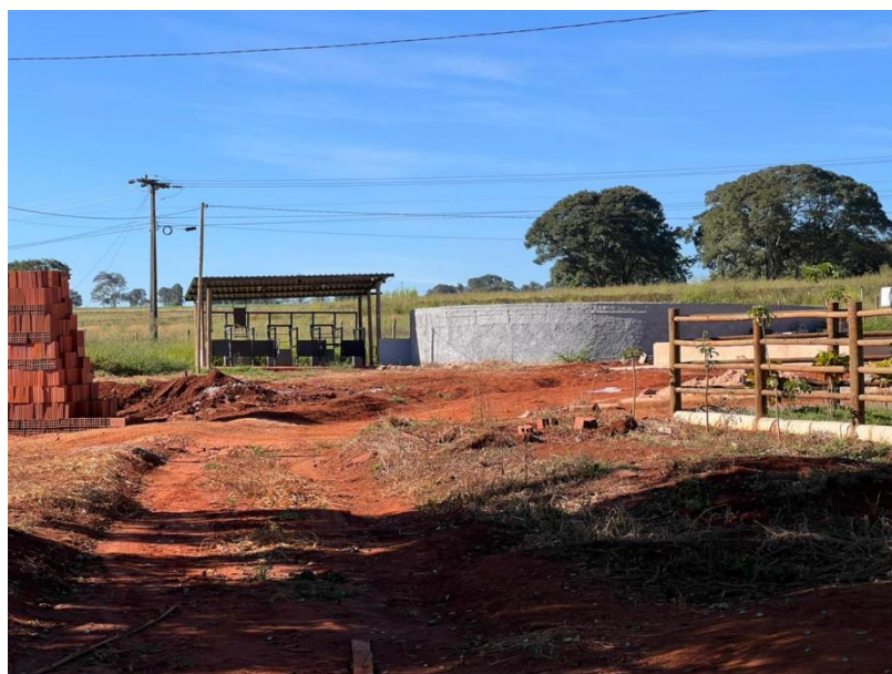
Figura 3 – Contenção e Redondel – Fonte: Autoria Própria
