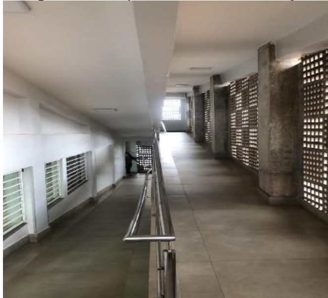
Figura 5: Rampa de acesso a internação
