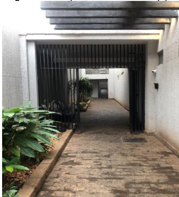
Figura 4: Rampa de acesso a recepção
