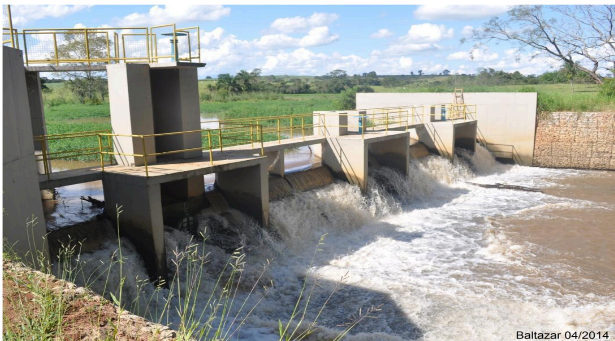
Figura 1: Sistema de tratamento de água de Inhumas Fonte: Baltazar, 2014
