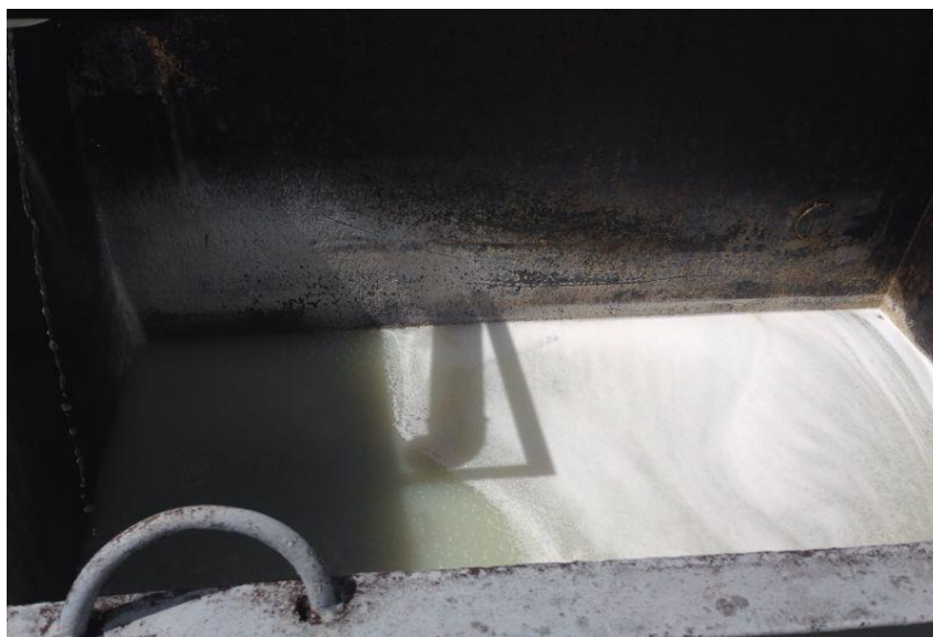
Figura 05: Separação grosseira de gordura. Fonte: Foto retirada pelas autoras do trabalho.
