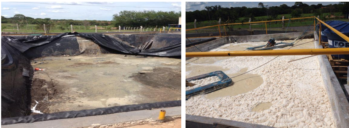
Figura 07: Lagoa de Aeração (Lodo Ativado). Fonte: Foto retirada pelas autoras do trabalho.
