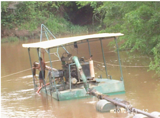
Figura (02). Ponto I - Córrego das Pedras com draga em funcionamento.
