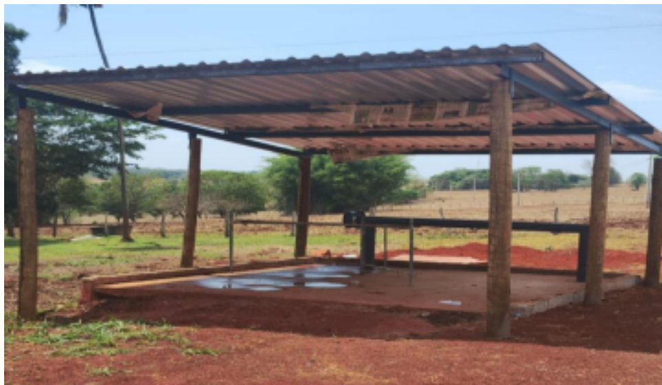
Figura 7 - Construção de Lavador coberto – Fonte: Autoria Própria
