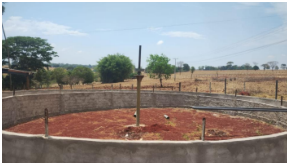
Figura 4 - Construção do Walker – Fonte: Autoria Própria
