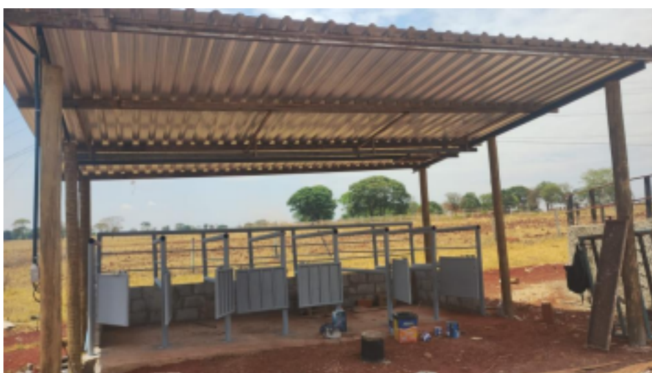
Figura 6 - Construção de Área de contenção – Fonte: Autoria Própria
