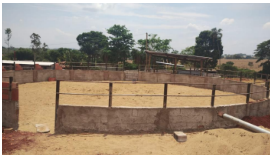
Figura 5 - Construção do Redondel – Fonte: Autoria Própria
