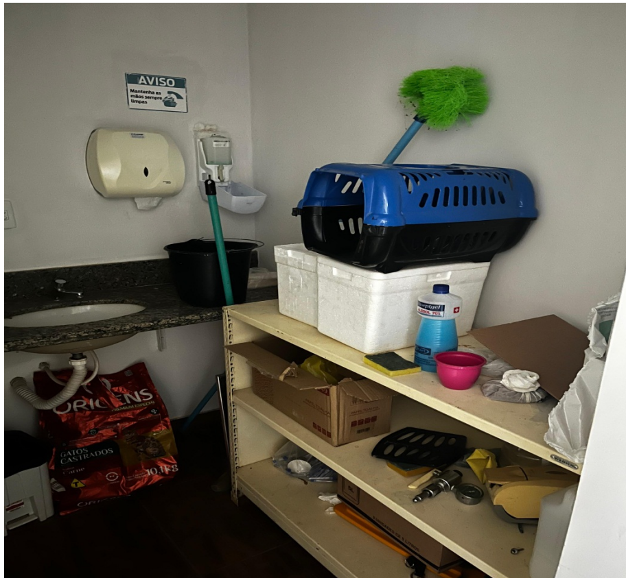
Figura 10 – DML ( Depósito de material de limpeza).
