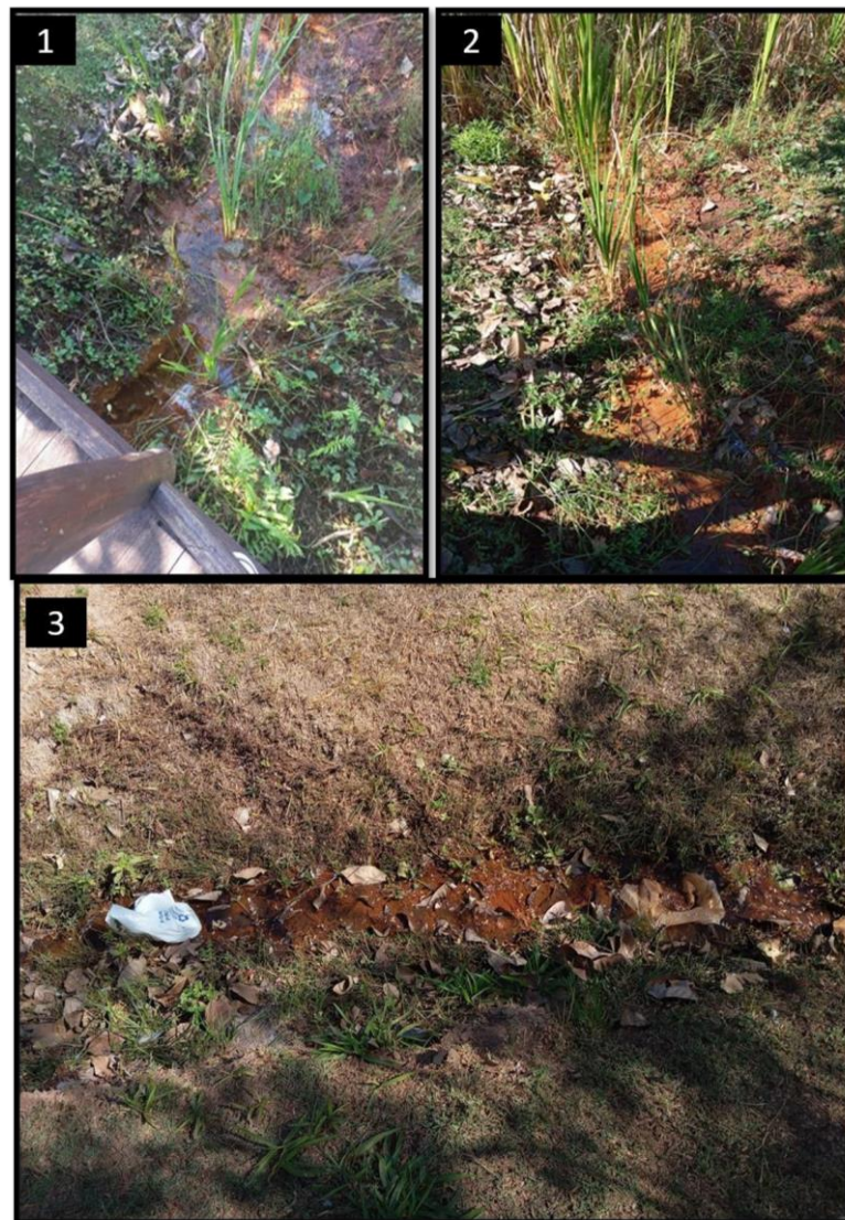
Figura 7 – Vista das nascentes 1 e 2 do parque Maria Pires Perillo. Na imagem 3 é observado resíduo plástico na superfície da nascente 2.
