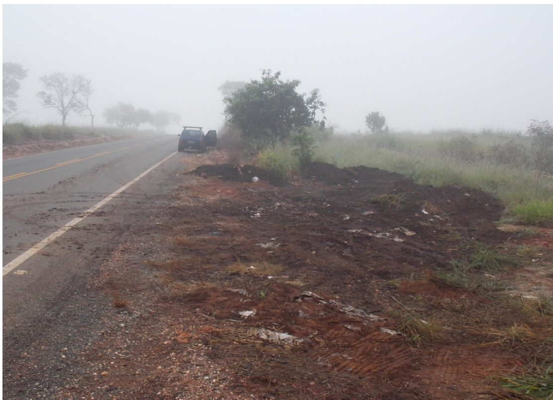
Fig 13: depois da retirada do lixo. Fonte os autores.
