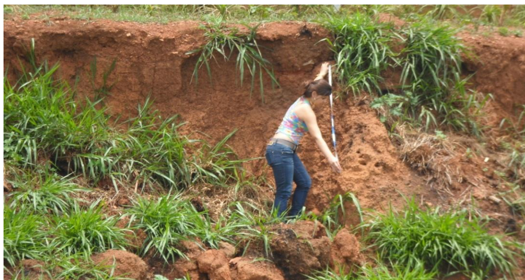
Figura G: Erosão localizada ao lado da nascente. (Foto: Ana Lúcia)
